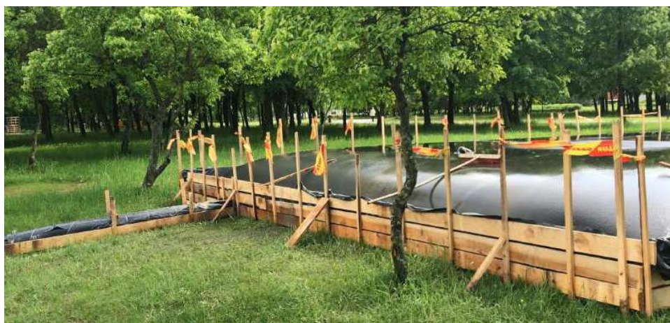
9 pav. Dumblo sausinimo (nuvandeninimo) maišas su apsauginėmis sienelėmis ir filtrato nuvedimu į vandens telkinį.
