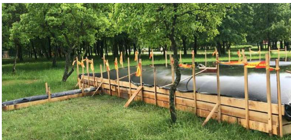
8 pav. Dumblo sausinimo (nuvandeninimo) maišas su apsauginėmis sienelėmis ir filtrato nuvedimu į vandens telkinį.
